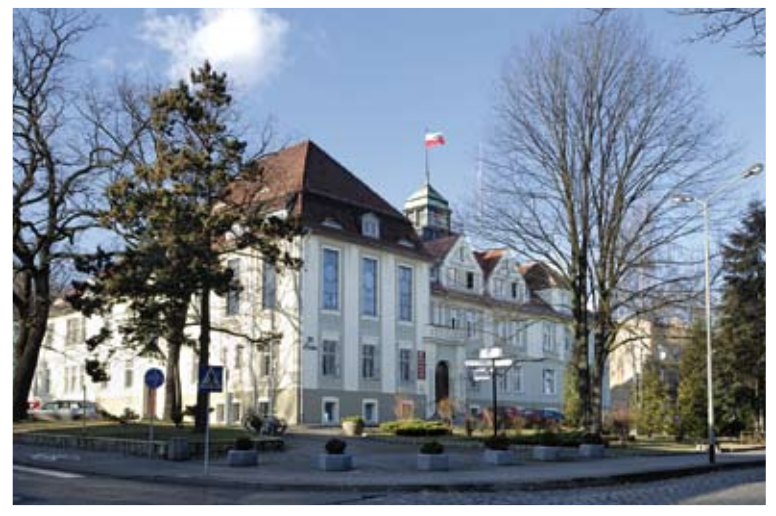
100-letni budynek Urzędu Miejskiego i Starostwa Powiatowego / 100 Jahre Stadt- und Landratsamt / 100-year old building of the Community and County Office
